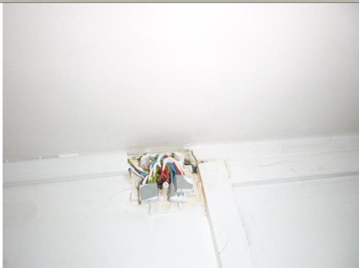
Description : Au moins un conducteur isolé n'est pas placé sur toute sa longueur dans un conduit, une goulotte, une plinthe ou une huisserie, en matière isolante ou métallique, jusqu'à sa pénétration dans le matériel électrique qu'il alimente.
