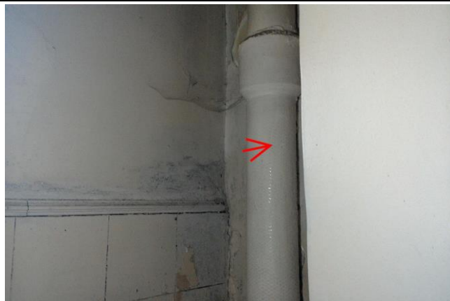
003 : amiante ciment salle d'eau/Wc
