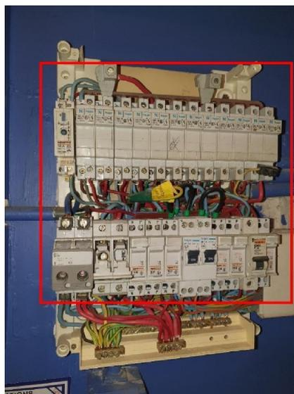
**B.4.3 a2)** : Au moins un dispositif de protection contre les surintensités n'est pas placé sur un conducteur de phase.
