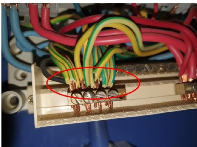
**B.3.3.6 c)** : La section du conducteur de protection, d'au moins un circuit est insuffisante.
