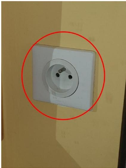
**B.6.3.1 a)** : Local contenant une baignoire ou une douche : l'installation électrique ne répond pas aux prescriptions particulières appliquées à ce local (adéquation entre l'emplacement où est installé le matériel électrique et les caractéristiques de ce dernier - respect des règles de protection contre les chocs électriques liées aux zones).
