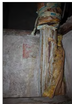
Photo N° 100 AMIANTE CIMENT - 2ème-Accès Toit Conduits de fluide Ventilation haute
