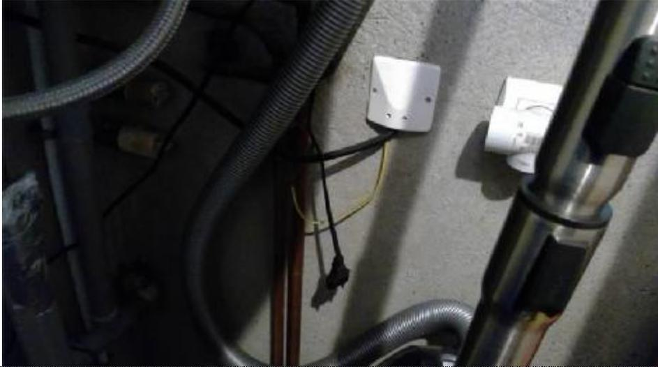
Description : La section du CONDUCTEUR de la LIAISON EQUIPOTENTIELLE principale est insuffisante.
