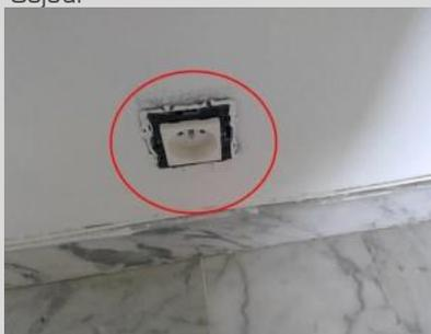
L'enveloppe du matériel est manquante ou détériorée. Les protections électriques doivent être entières et non dégradées pour que les occupants soient en sécurité à tout instant.
