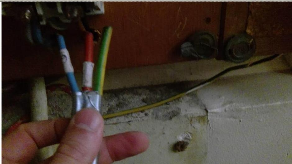
**Description :** La section des CONDUCTEURS de la CANALISATION alimentant le seul tableau n'est pas adaptée au courant de réglage du DISJONCTEUR de branchement.
